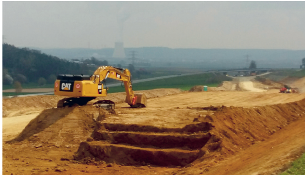
Baustelle B15neu bei Essenbach
